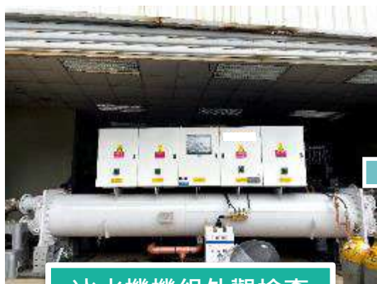
冰水機機組外觀檢查
